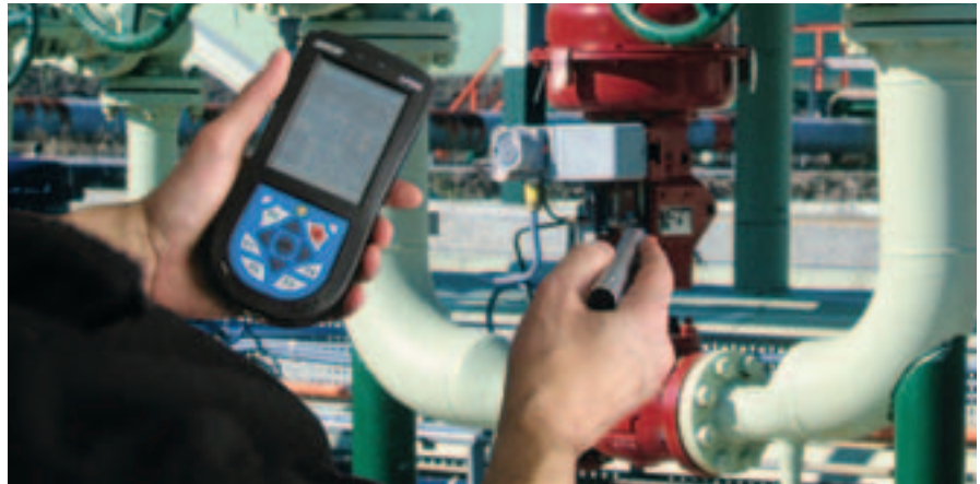
Auslesen der Wartungshistorie einer Pumpe aus im Gehäuse eingelassenem Tag
